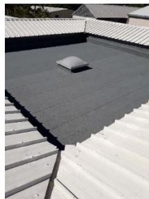
Mise en œuvre d'un complexe d'étanchéité bicouche avec isolant
